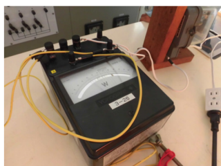
電力量計の誤差試験
