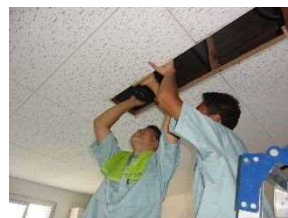
取り外し完了↓
