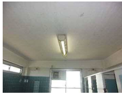
↑交換前（トイレ室内）↑
