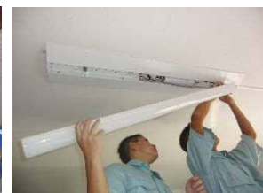
LED照明取付け↓
